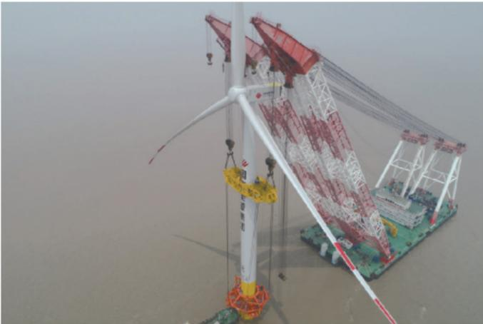
2019年8月17日，世界首台单桩基础整体安装风电机组在江苏东台海上风电场吊装完成
