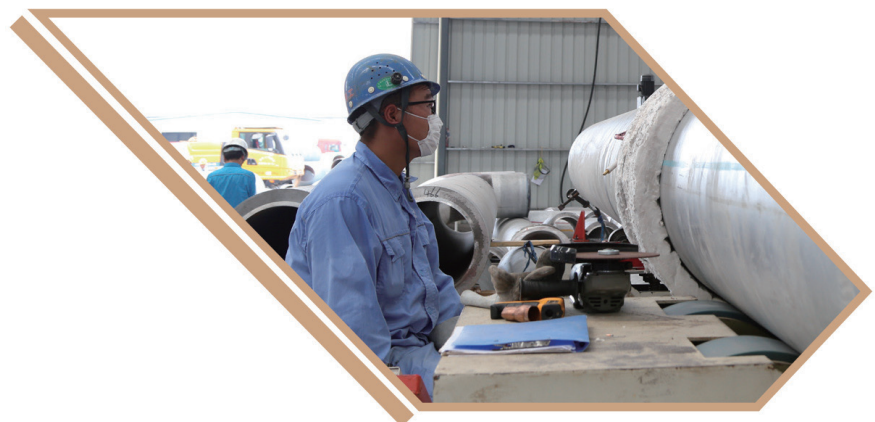
管道安装技术的创新有效推动高质量发展
