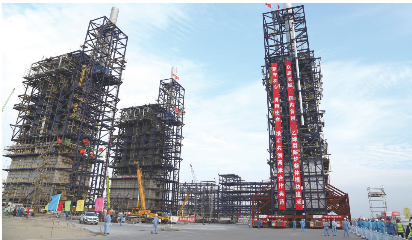
创新模块化施工，打出十建公司“活招牌”
