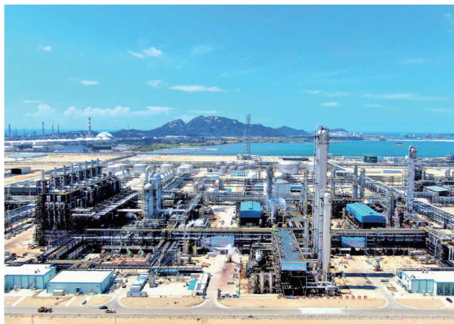
大型设备急冷油塔在建设现场吊装就位
