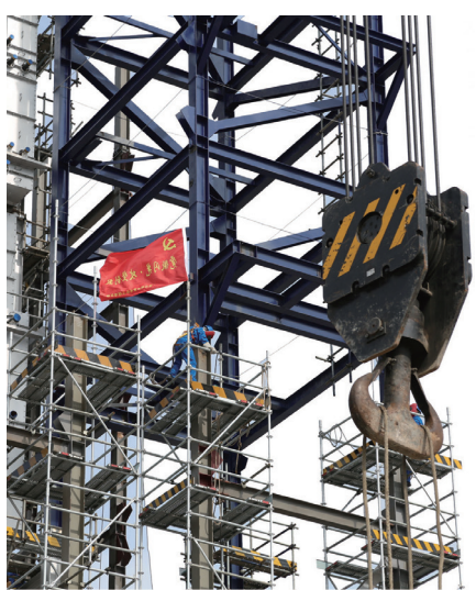
十建公司深入推进党建与项目建设深度融合 摄影 / 吴翠莲
